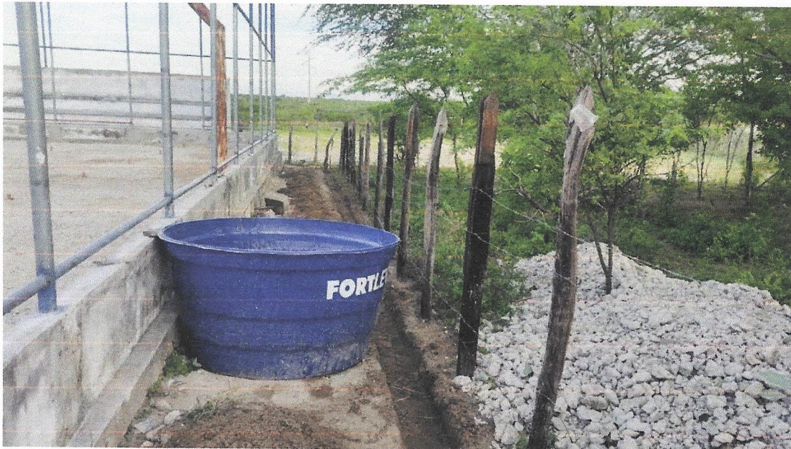
Foto 09 – ESCAVAÇÃO MANUAL DE VALA COM PROFUNDIDADE MENOR OU IGUAL A 1,30 M. AF_02/2021.
