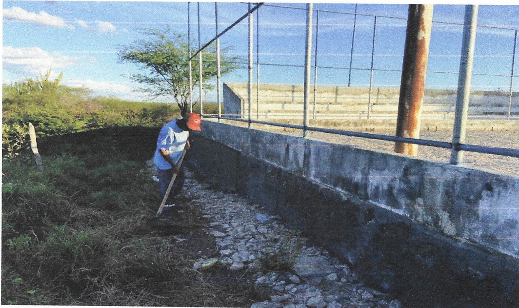
Foto 01 – LIMPEZA MANUAL DE VEGETAÇÃO EM TERRENO COM ENXADA.AF_05/2018
