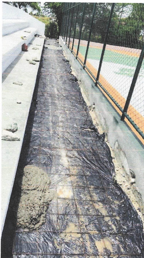
Foto 11 – Aplicação de lona plástica e tela aço soldada nervurada CA-60, malha 15x15cm, ferro 4.2mm, painel 2x3m.
