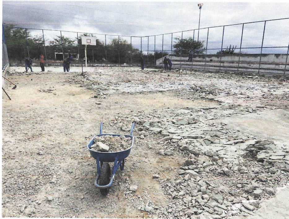
Foto 03 – Demolição de concreto com martelete e compressor
