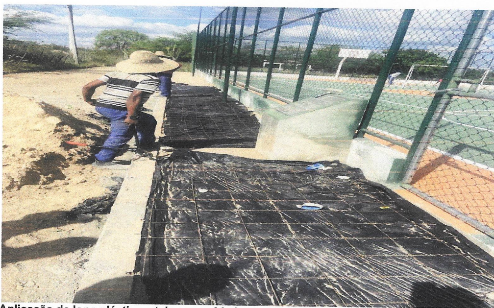
Foto 12 Aplicação de lona plástica e tela aço soldada nervurada CA-60, malha 15x15cm, ferro 4.2mm, painel 2x3m.
