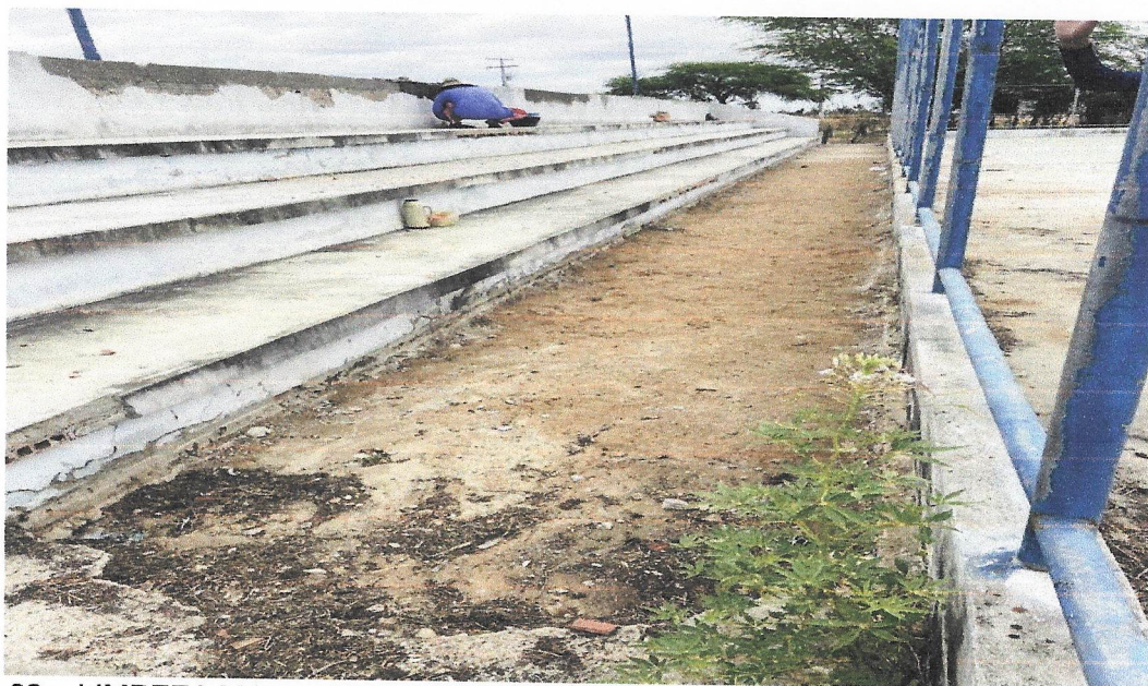
Foto 02 – LIMPEZA MANUAL DE VEGETAÇÃO EM TERRENO COM ENXADA.AF_05/2018
