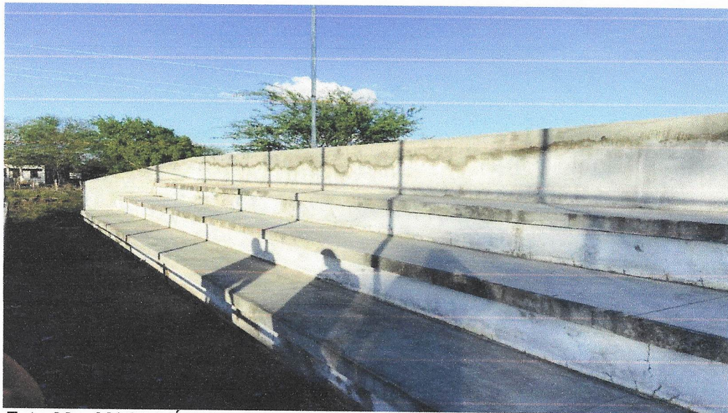
Foto 06 – MASSA ÚNICA, PARA RECEBIMENTO DE PINTURA OU CERÂMICA, ARGAMASSA INDUSTRIALIZADA, PREPARO MECÂNICO, APLICADO COM EQUIPAMENTO DE MISTURA E PROJEÇÃO DE 1,5 M3/H EM FACES INTERNAS DE PAREDES, ESPESSURA DE 5MM, SEM EXECUÇÃO DE TALISCAS. AF_06/2014
