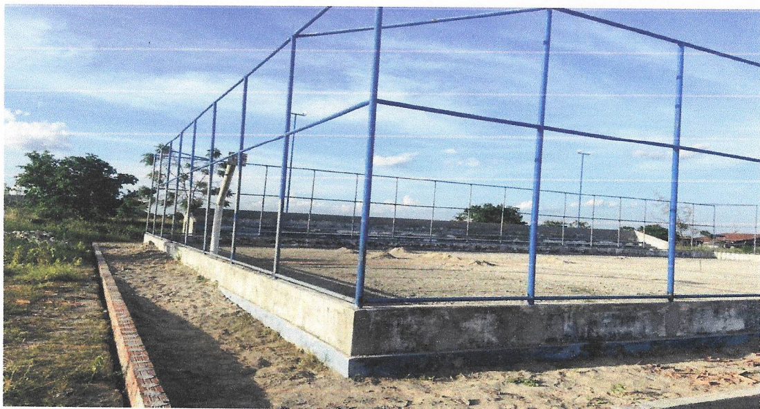
Foto 10 – ALVENARIA DE VEDAÇÃO DE BLOCOS CERÂMICOS FURADOS NA VERTICAL DE 9X19X39 CM (ESPESSURA 9 CM) E ARGAMASSA DE ASSENTAMENTO.
