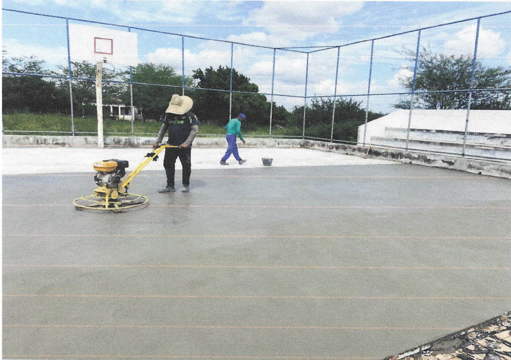
Foto 15 – ACABAMENTO POLIDO PARA PISO DE CONCRETO ARMADO OU LAJE SOBRE SOLO DE ALTA RESISTÊNCIA. AF_09/2021.
