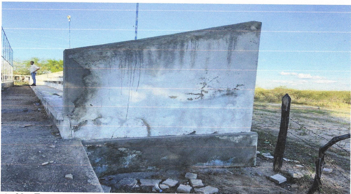
Foto 08 – Tratamento de fissuras com argamassa industrializada massa rápida Rebotec ou similar (Seção até 5 x 5 cm)
