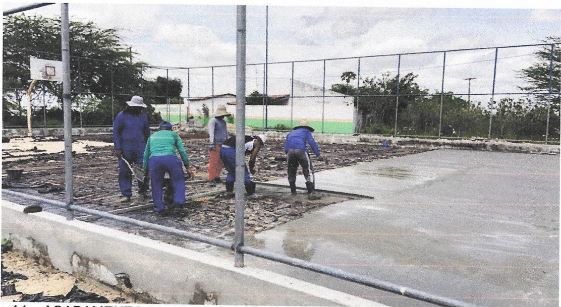
Foto 14 – ACABAMENTO POLIDO PARA PISO DE CONCRETO ARMADO OU LAJE SOBRE SOLO DE ALTA RESISTÊNCIA. AF_09/2021.
