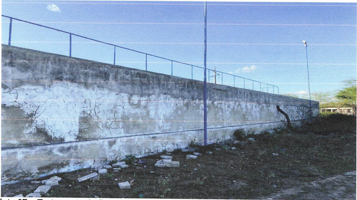
Foto 07 – Tratamento de fissuras com argamassa industrializada massa rápida Rebotec ou similar (Seção até 5 x 5 cm).
