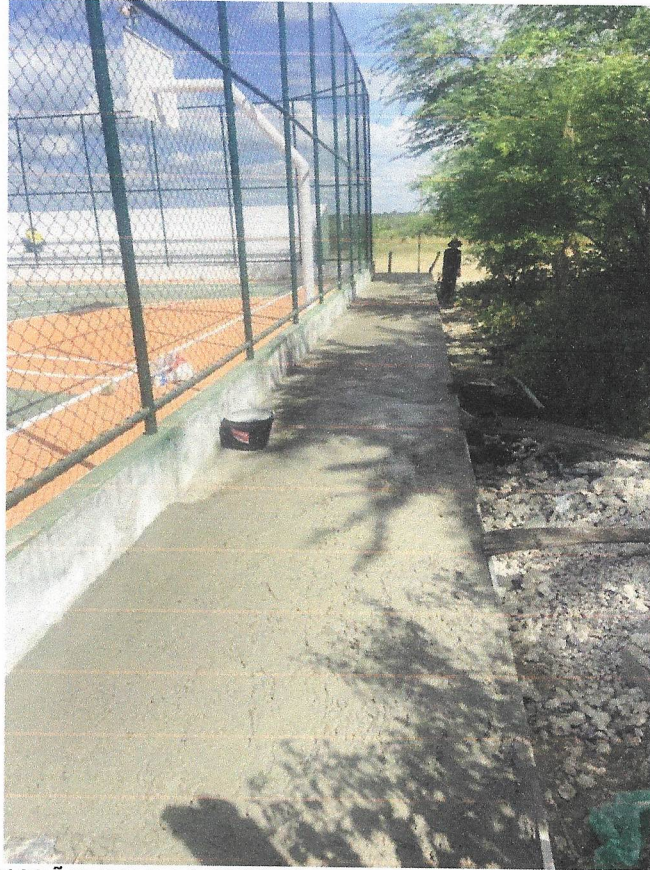
Foto 13 – EXECUÇÃO DE PASSEIO (CALÇADA) OU PISO DE CONCRETO COM CONCRETO MOLDADO IN LOCO, FEITO EM OBRA.
