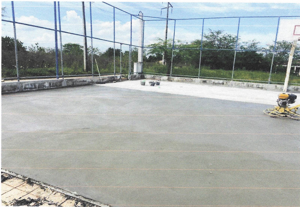
Foto 16 – ACABAMENTO POLIDO PARA PISO DE CONCRETO ARMADO OU LAJE SOBRE SOLO DE ALTA RESISTÊNCIA. AF_09/2021.
